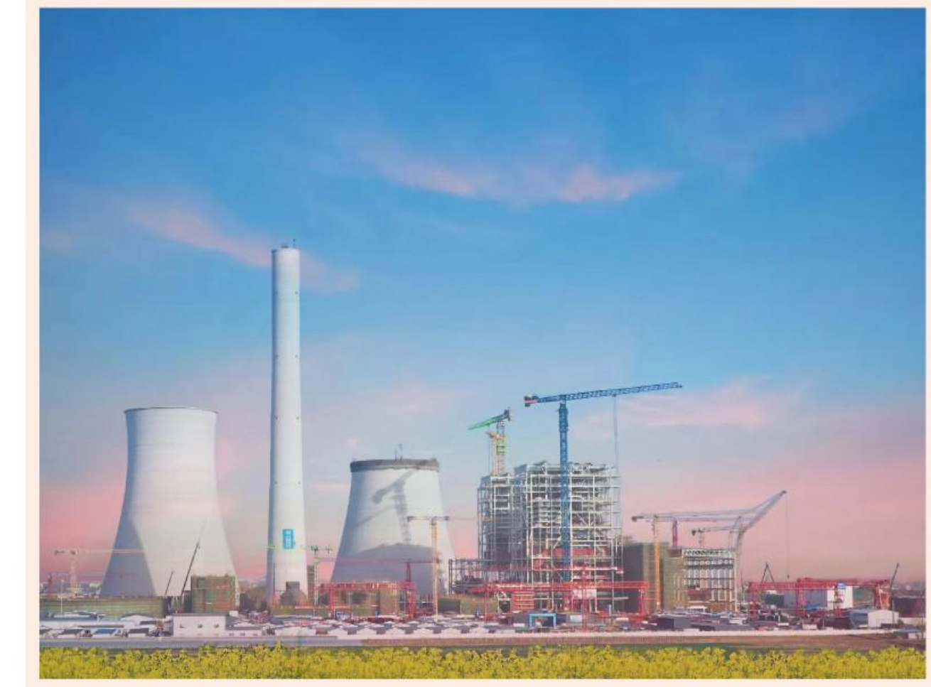
潘集电厂项目部战疫情保生产,加紧施工不停歇,图为主厂房区域。(李萍摄)
