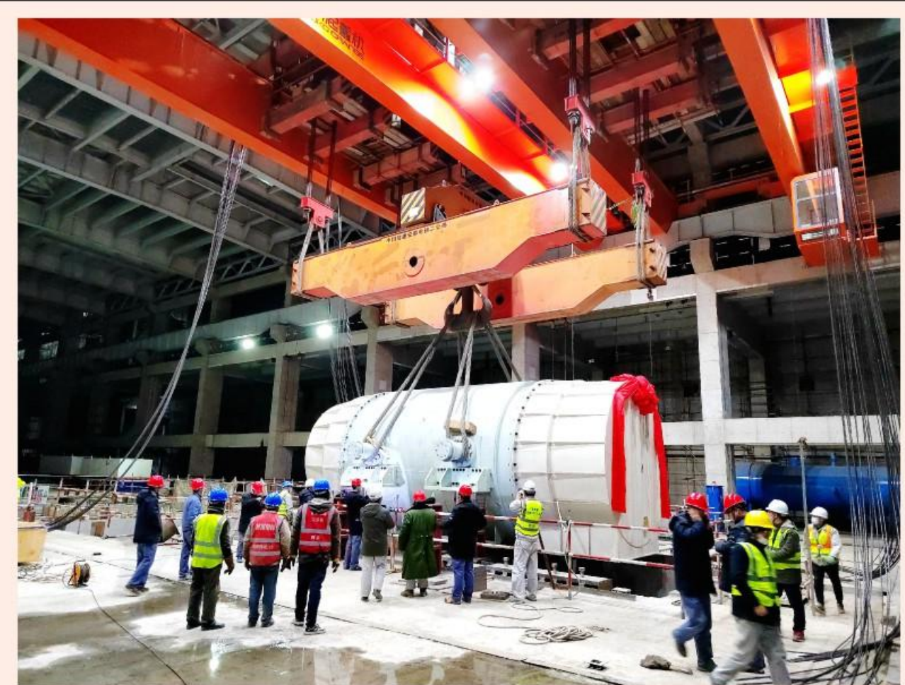
3月25日,内蒙古京宁二期工程4号发电机组进行了吊装完成。(黄小林摄)
