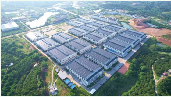
110千伏升压站。项目采用农光互补的绿色发展方案，建成后首年发电量为16976.4万千瓦时。
