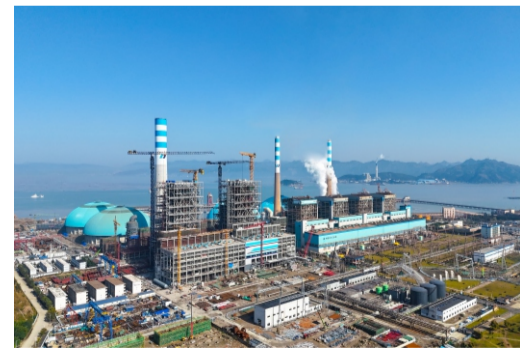
福建华电可门三期百万机组项目（杜金行摄）
