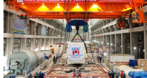
江西新余电厂二期工程2号机组汽轮机发电机定子就位（林绪摄）
