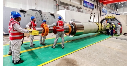
安徽板集电厂二期工程3号机组发电机转子穿装完成（赵熹摄）
